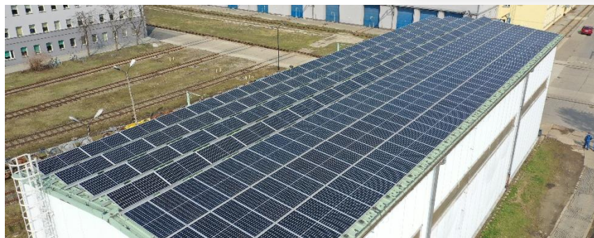
Budowa instalacji fotowoltaicznej
